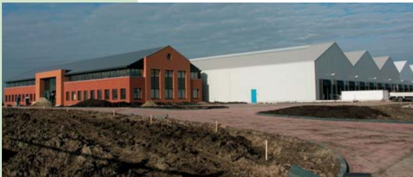
Het kantoregebouw (links) met hal en laaddocks
