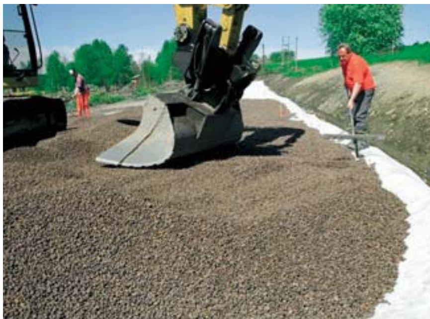
De kleikorrels kunnen in de agrarische bouw worden toegepast als fundatie of bij ophoging van wegen of kavelwegen
