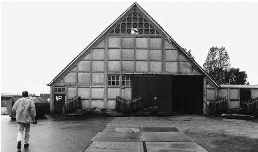
De topgevels van de Schokbetonschuren hebben een vakwerkachtig karakter
