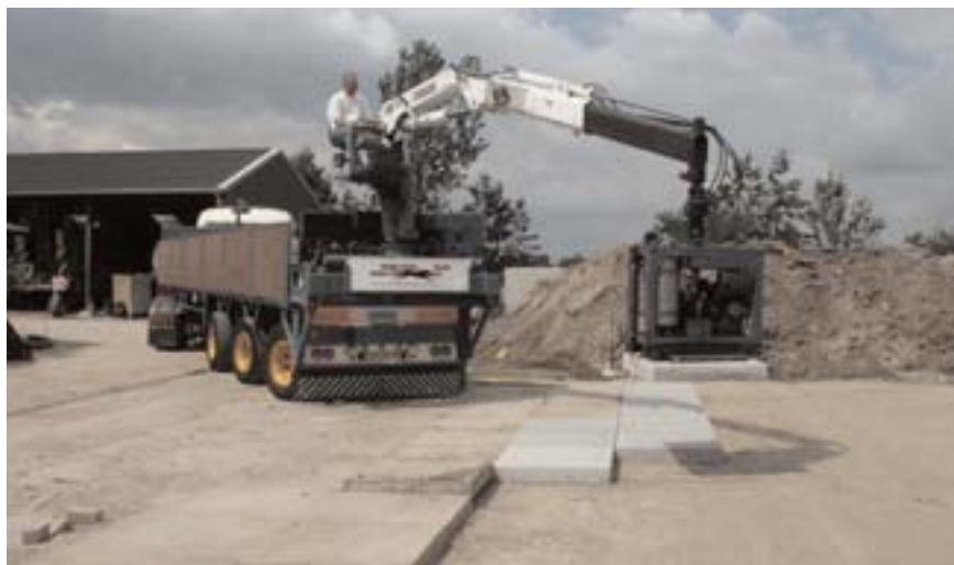
De ondergrond voor een prefab vloer moet meestal uit een schoon aangetrild zandbed bestaan
