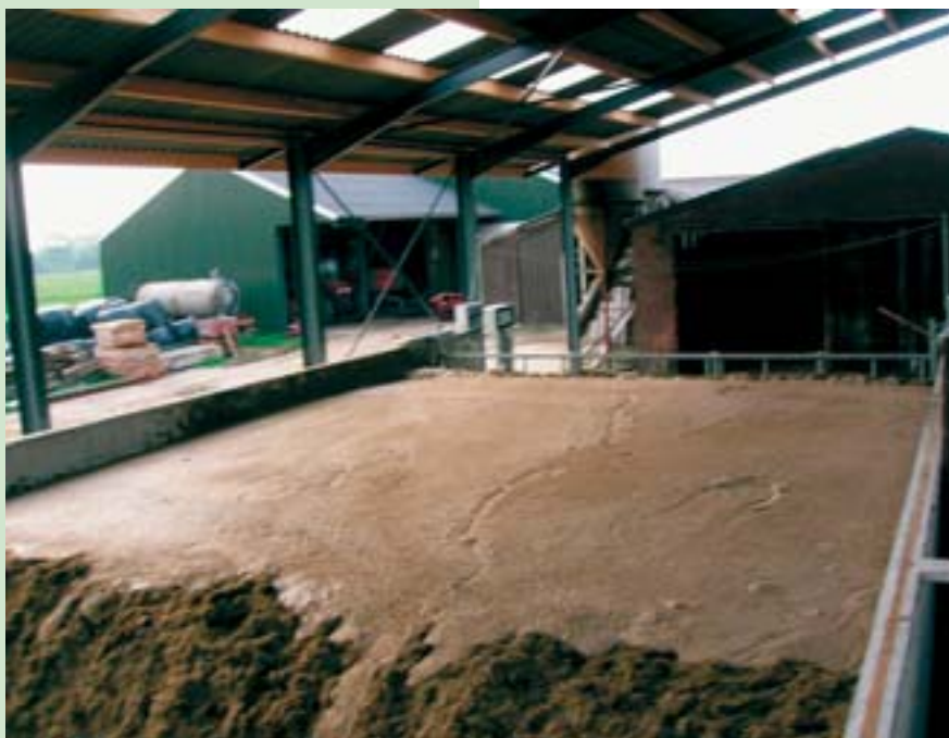
De bouw van de sleufsilos
