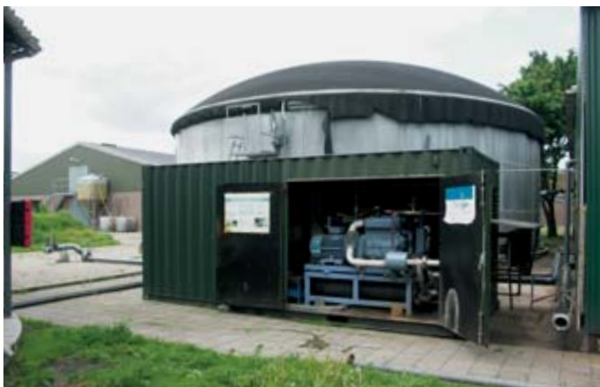
Een volledig geroerde vergister - 615 m 3 - bij Praktijkcentrum Sterksel
