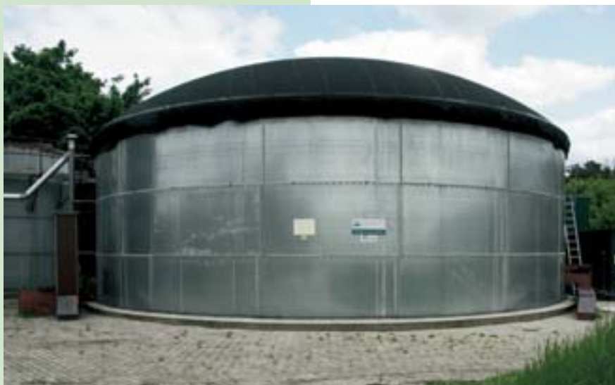
In de vergister wordt de mest verwarmd en doen bacteriën hun werk
