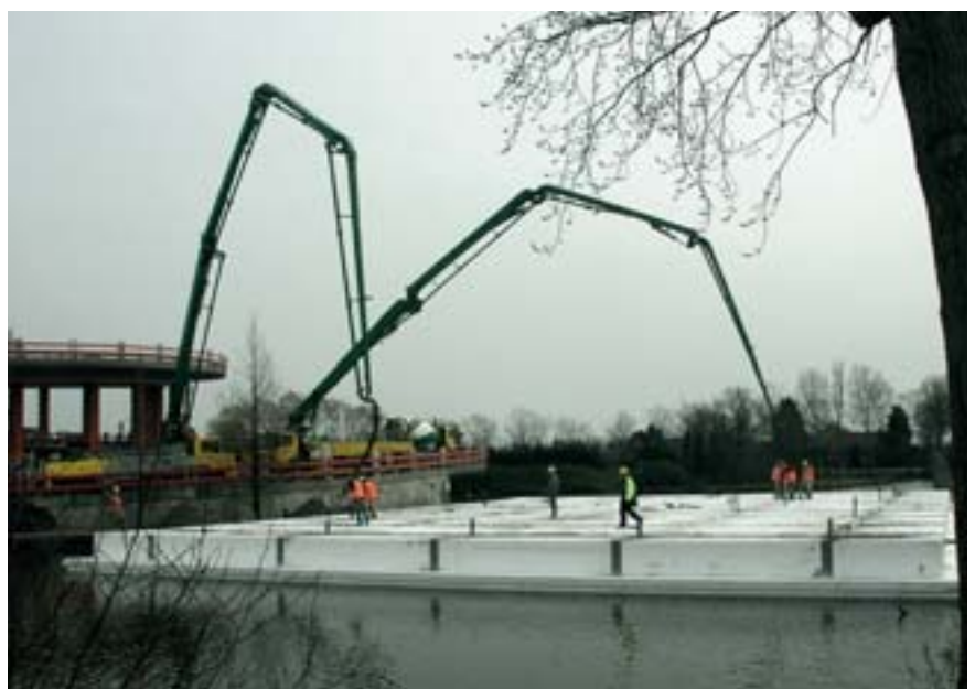
Betonpompen brengen het beton voor de funderingsbalken gelijktijdig op twee plaatsen in het werk
