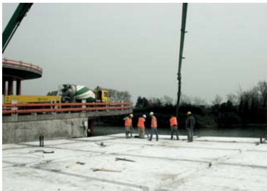
De spelingen tussen de EPS-blokken vormen de structuur van de funderingsbalken
