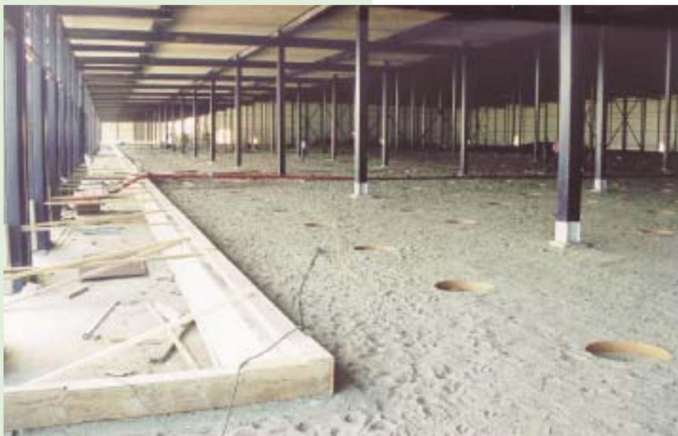
Ruimte waarin de staalvezelbetonvloer wordt gestort
