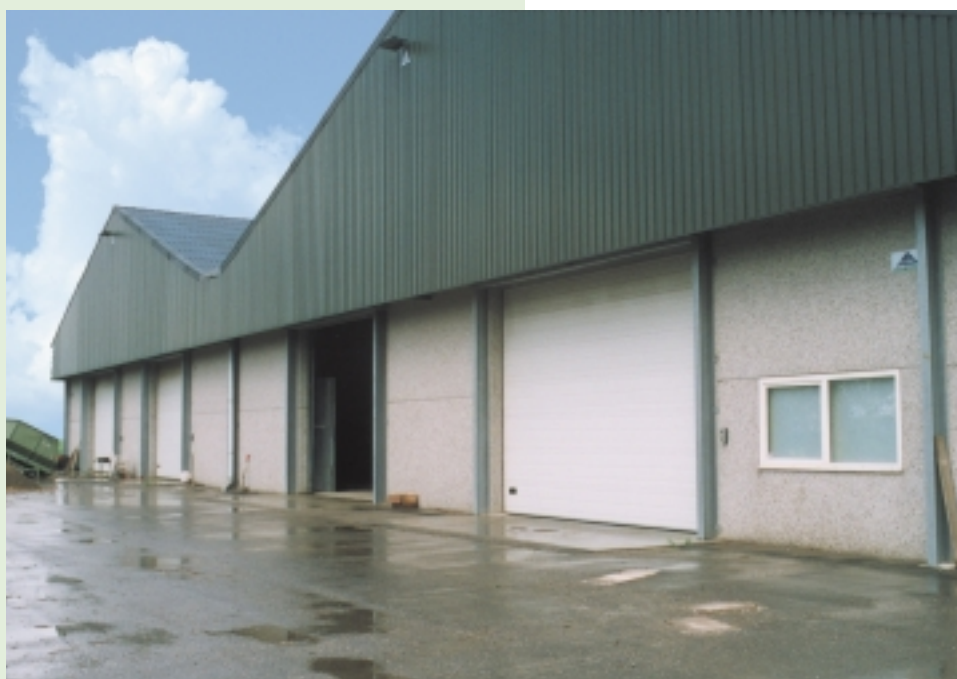
De aardappelbewaarloods heeft de spanten aan de buitenkant van de gevelelementen
