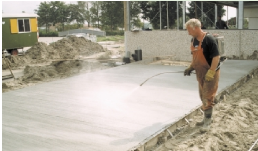
Curing compound aanbrengen op gedeelte van de erfverharding
