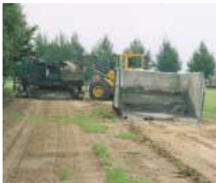
Betonspecie wordt gebruikt voor het aanleggen van een kavelpad
