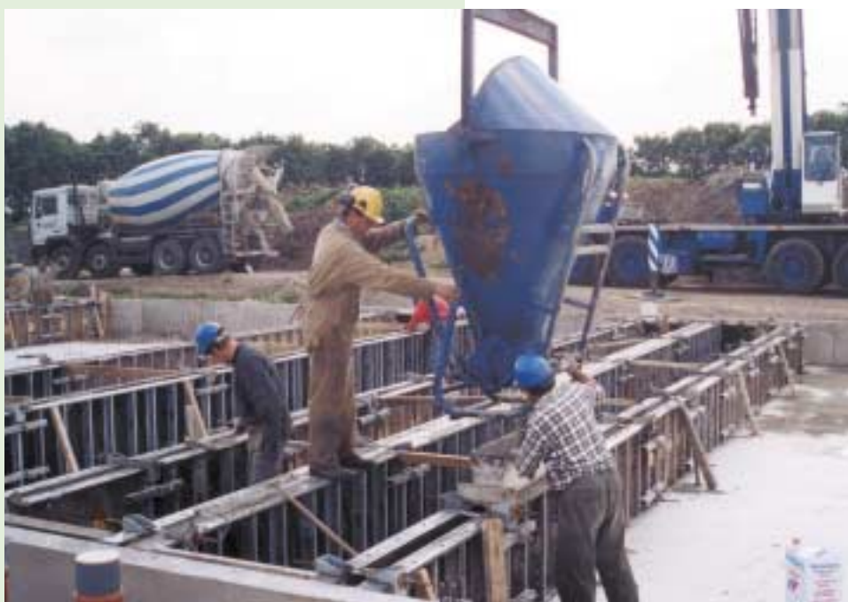
Kubelen van betonspecie voor kelderwanden van een varkensstal
