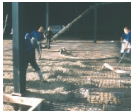
Het aanleggen van een betonvloer
