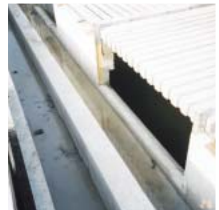
Sparing in kelderwand voor overstort drijfslag in mestgrup
