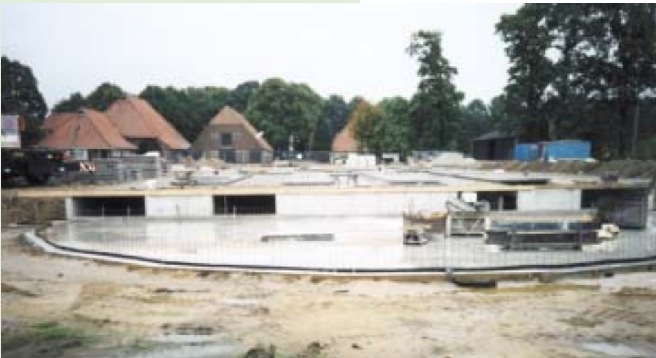
De bouw van de kelder met op de voorgrond de keldervloer van de halfronde potstal
