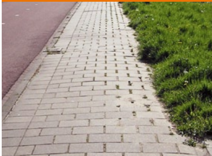
Een testbaan van ruim 100 meter had gemiddeld 3 procent groenoppervlak. De verspoten hoeveelheid vloeistof is bepaald via het opvangen van vloeistof in zakjes of door afname in het reservoir. Onkruidstrijkers hadden het laagste verbruik, daarna de sensorgestuurde technieken en daarna de schijfvernevelaars.
