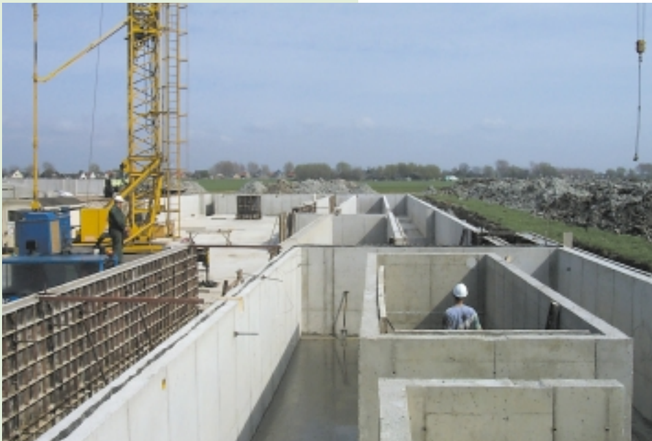
De mestkelder in aanbouw
