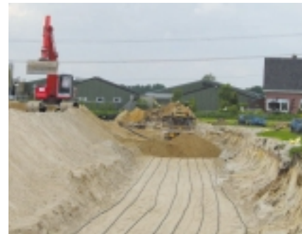
Aanbrengen van de leidingen voor het wisselbed
