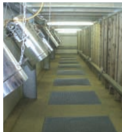
Kachels blazen warme lucht rechtstreeks in de ventilators
