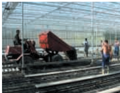
Een 'japper' voert de betonspecie aan
