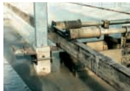
De trilbalk wordt op rollen voortbewogen
