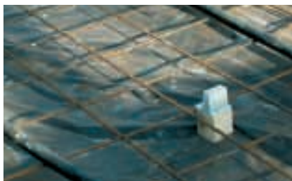
Op een kunststofspijkerklos wordt een gootmal gesteld
