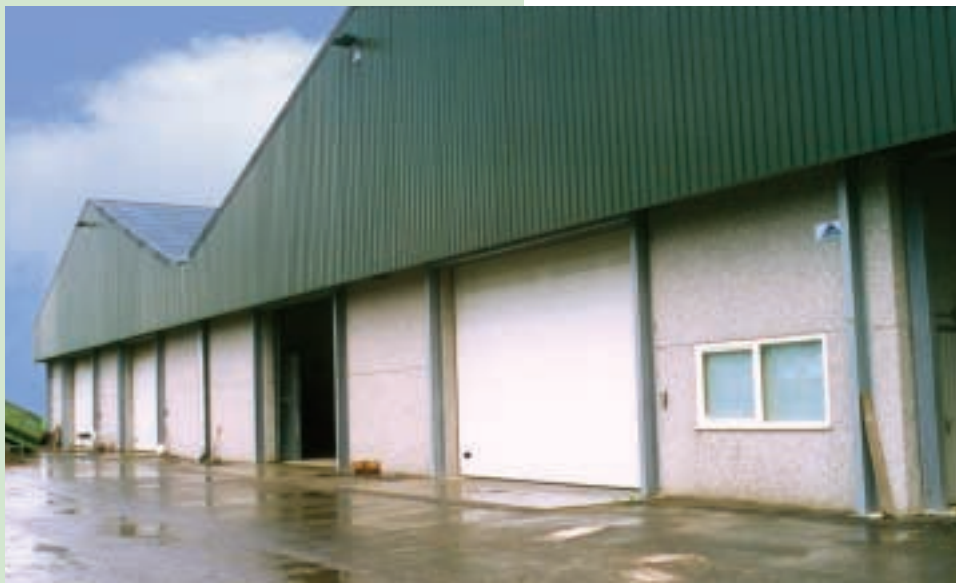
In deze bewaarschuur zijn over het totale bewaaroppervlak prefab betonroosters aangebracht
