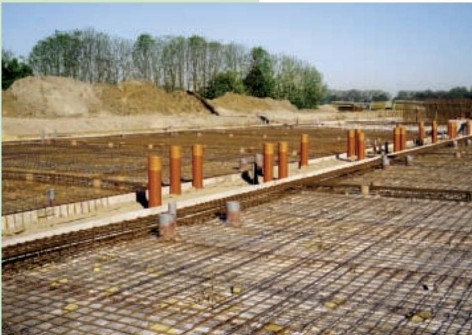
De dekking heeft een beschermende functie om roesten van beton tegen te gaan
