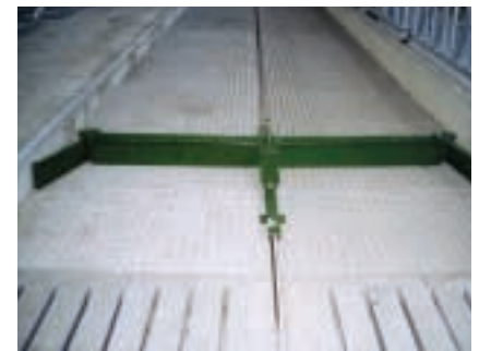
Dichte vloer in ter plaatse gestort beton met Agriprint motief
