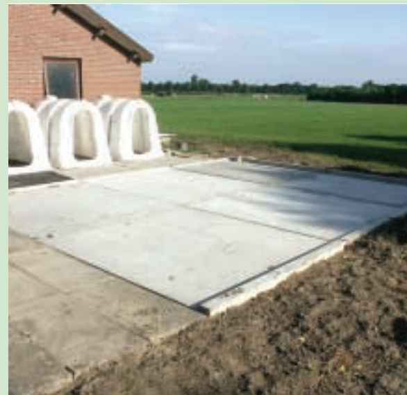
Een prefab reinigingsplaats van Fabiton
