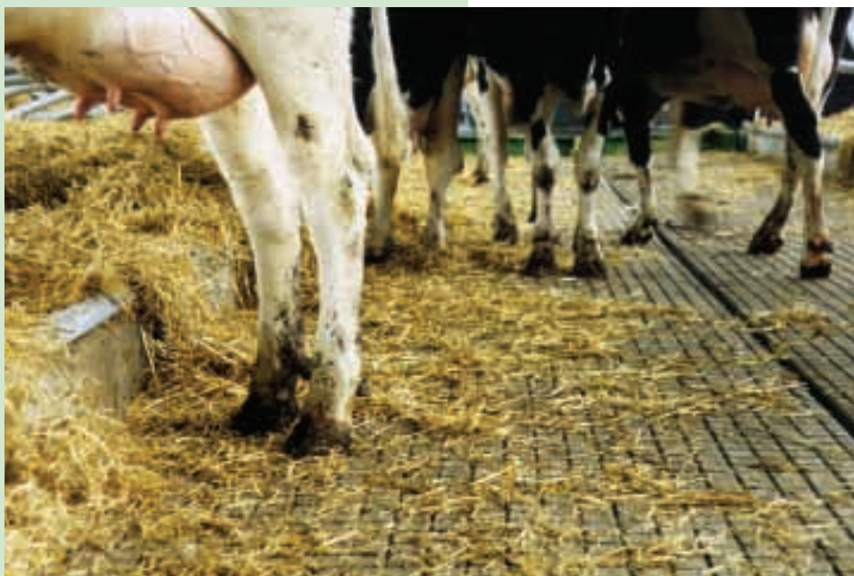
Op de universiteit Gent werd onderzoek gedaan naar de relatie tussen betonvloer en rundveeklauw
