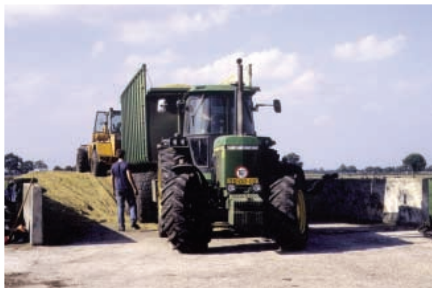
Vanwege de grote belastingen dienen sleufsilos constructief worden uitgevoerd
