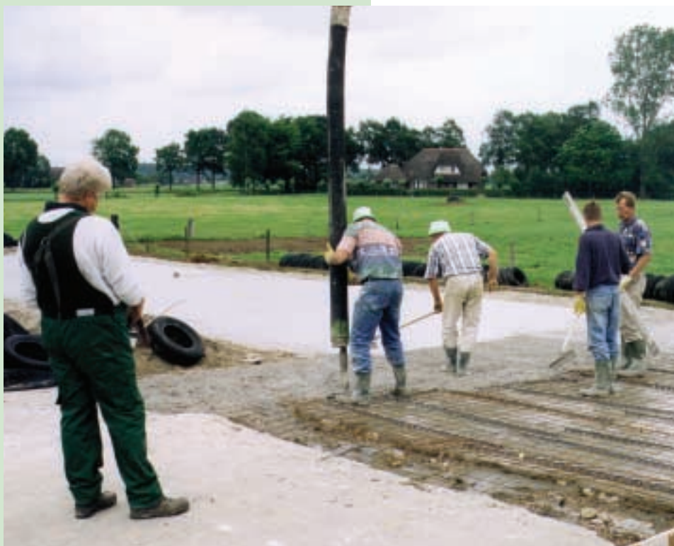
Renovatie van een kuilvoerplaat met 8 cm dik beton
