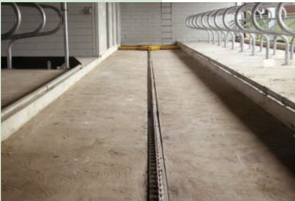
Tweezijdig dichte hellende betonvloer in de mestgang van het Lagekostenbedrijf in Lelystad
