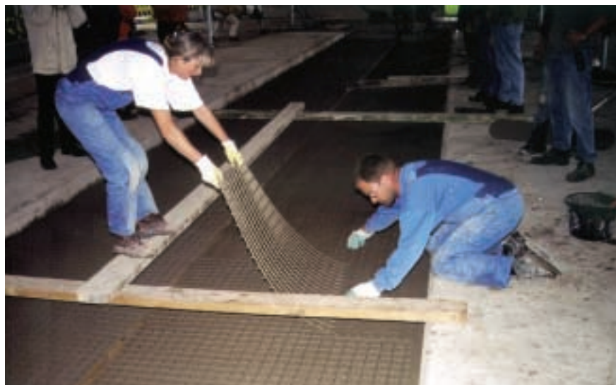
Bij de printvloer wordt de printmat steeds verwijderd uit de nog verse betonspecie
