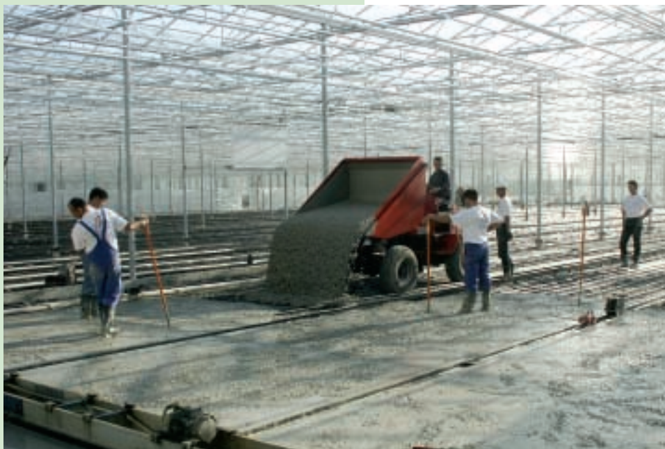
De wijze van in het werk brengen van de specie bepaalt mede de gewenste plasticiteit
