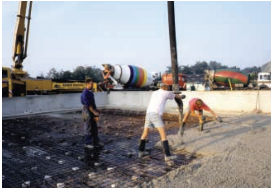
Door toename van het gebruik van een betonpomp neemt het gebruik van hulpstoffen toe
