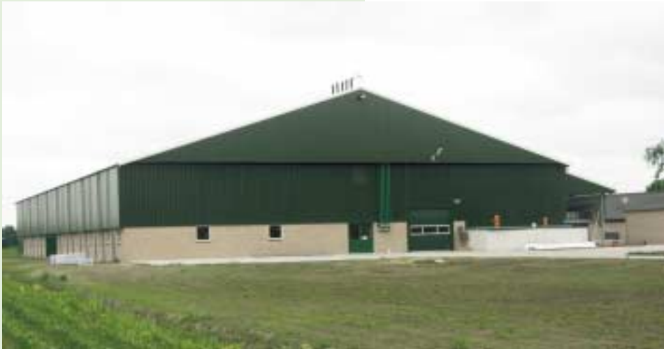
De etagestal biedt plaats aan 957 fokzeugen en zo'n 3.120 biggen
