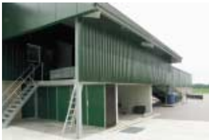
Via de hellingbaan komen de varkens bij het overdekte afleverplatform
