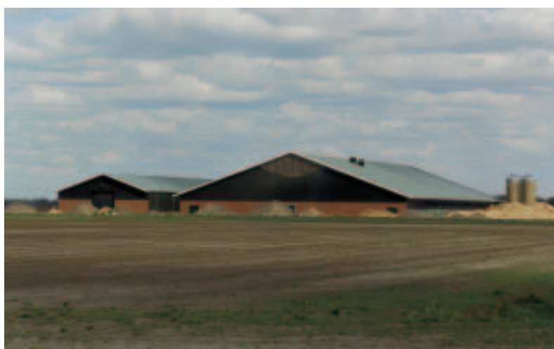
In het midden van de schuur bevindt zich onder de nok het ventilatierooster
