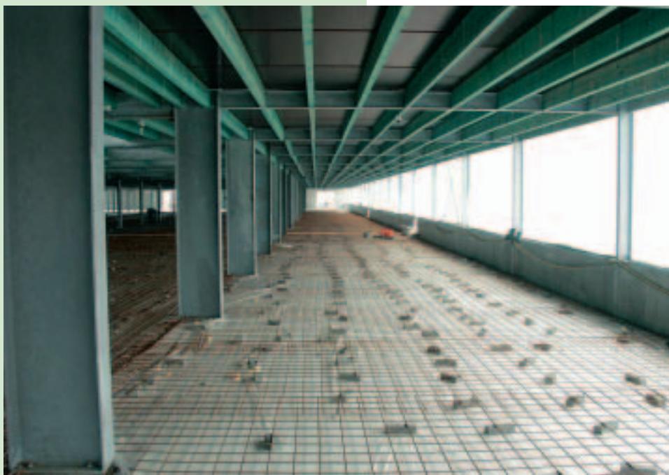
Vloerisolatie in de wintergarten – overdekte scharrelruimte – op de begane grond
