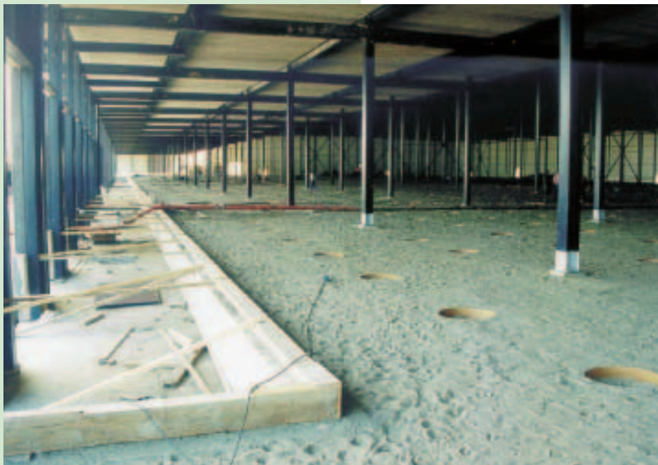
Bij het gebruik van staalvezelbeton ontbreekt veelal de traditionele (vloer)wapening
