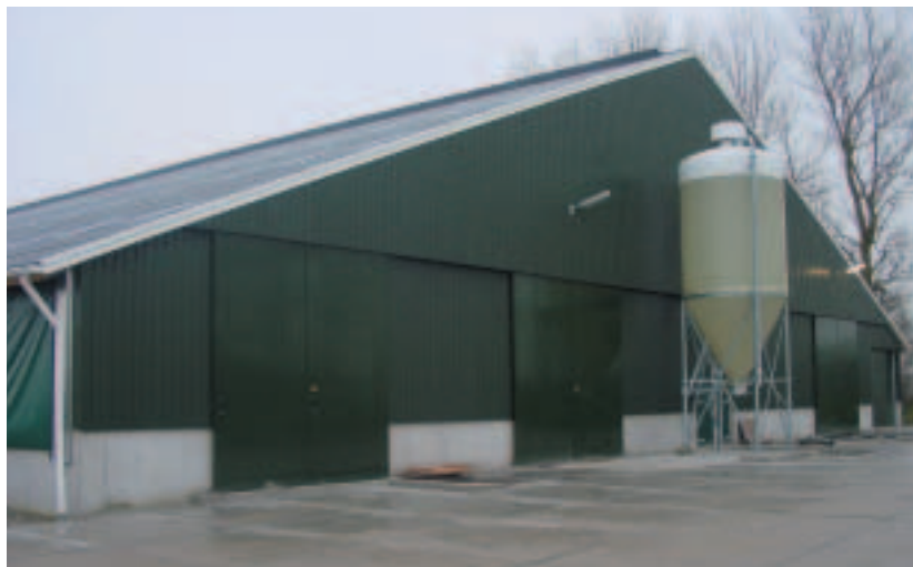
Achterzijde van de stal met de erfverharding van betonplaten
