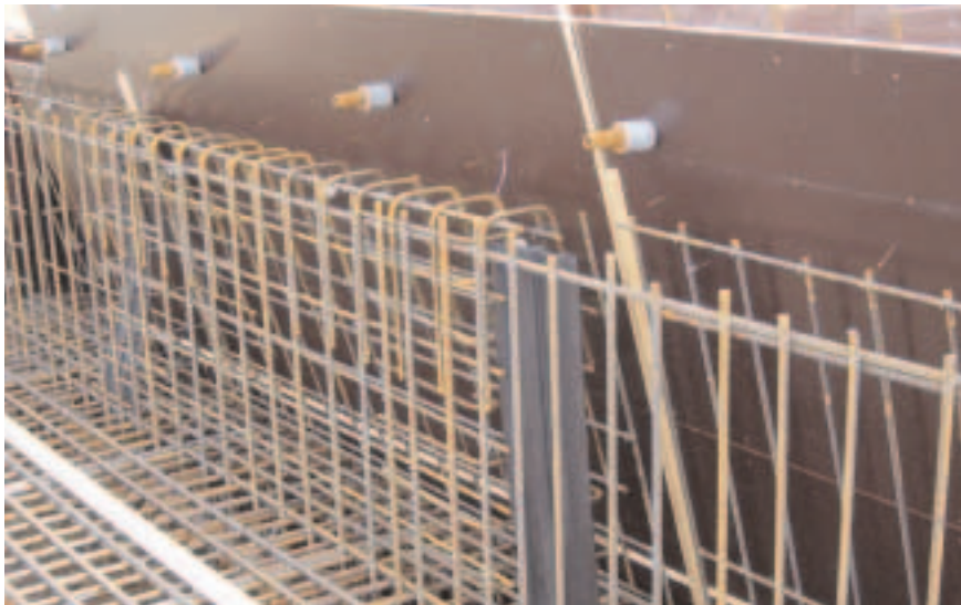
De VBU vermeldt dat nabehandeld moet worden totdat de betonsterkte in het oppervlak ten minste 50 % van de voorgeschreven sterkteklasse bedraagt
