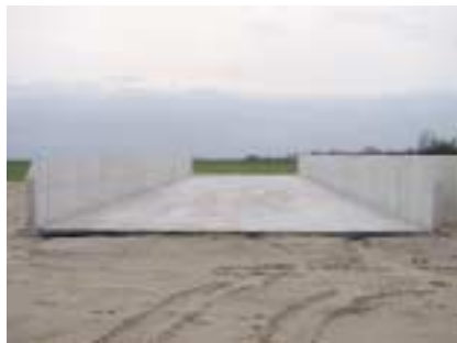
Per 1 oktober 2004 moet de eigenaar van een bedrijfsvloer een PBV-verklaring 'Vloeistofdichte Voorziening' kunnen tonen
