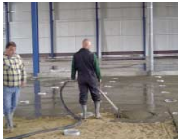
Waar de werkvloer van vloei beton wordt ingebracht zijn de paalkoppen met een ring van bandstaal uitgespaard
