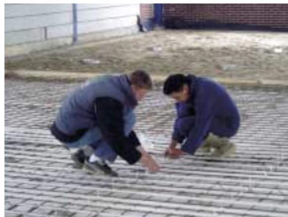
In de sorteerruimte worden de slangen van de vloerverwarming op het ondernet geknoopt
