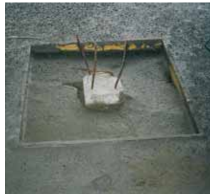
Puntvormig ondersteunde vloer: een paalkop na het 'snellen'. Zichtbaar is een kleine bekisting voor een kolomplaat (grotere vloerdikte rond de paal)
