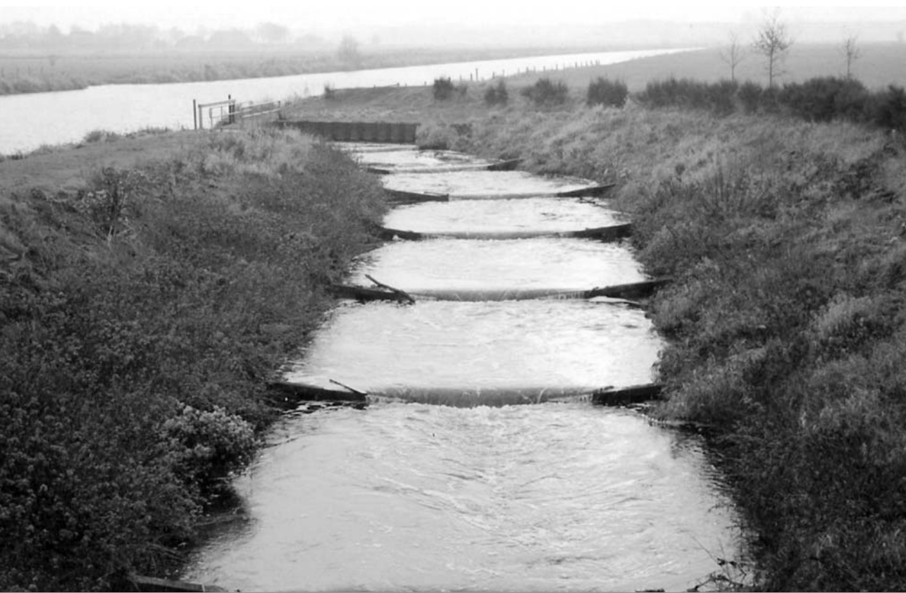
V-stepped fishway (F3) / Bekkenvistrap met V-vormige overlaten (Junne)
