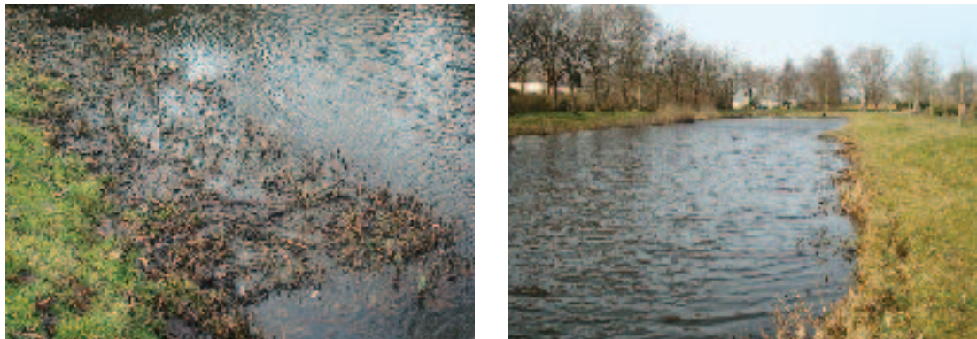
Fig 3.2 VOORBEELD VAN EEN ONDERWATERBAK IN DE WINTER (LINKS) EN EEN DRASBERM (RECHTS)
