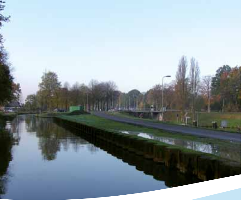
Figuur 2.4.1. Het aanvoerkanaaltje (links) en sluis 15 in de Zuid-Willemsvaart (rechts). Het water in het aanvoerkanaaltje wordt ingelaten bovenstrooms van de sluis en voedt (via een duiker onder het kanaal Wesseme-Nederweert) de Noordervaart.
