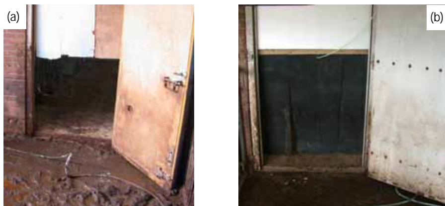
Figuur 6 Afdichting van de deuren tussen de afdeling en de uitloop. (a) tijdens meetperiode 1 t/m 3 (b) tijdens perioden 4 t/m 6
