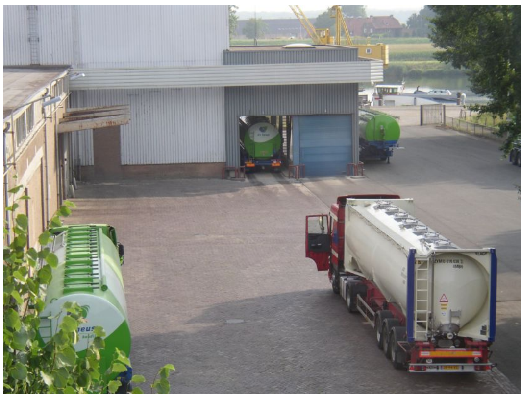
Laadstation met gemorst voer. Te zien is dat laaddeuren tegenover elkaar openstaan
