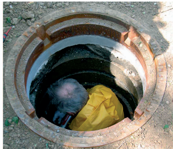
FIGUUR: 15 MET BEHULP VAN EEN TRAP DE IBA IN OM ONDERHOUD UIT TE VOEREN
