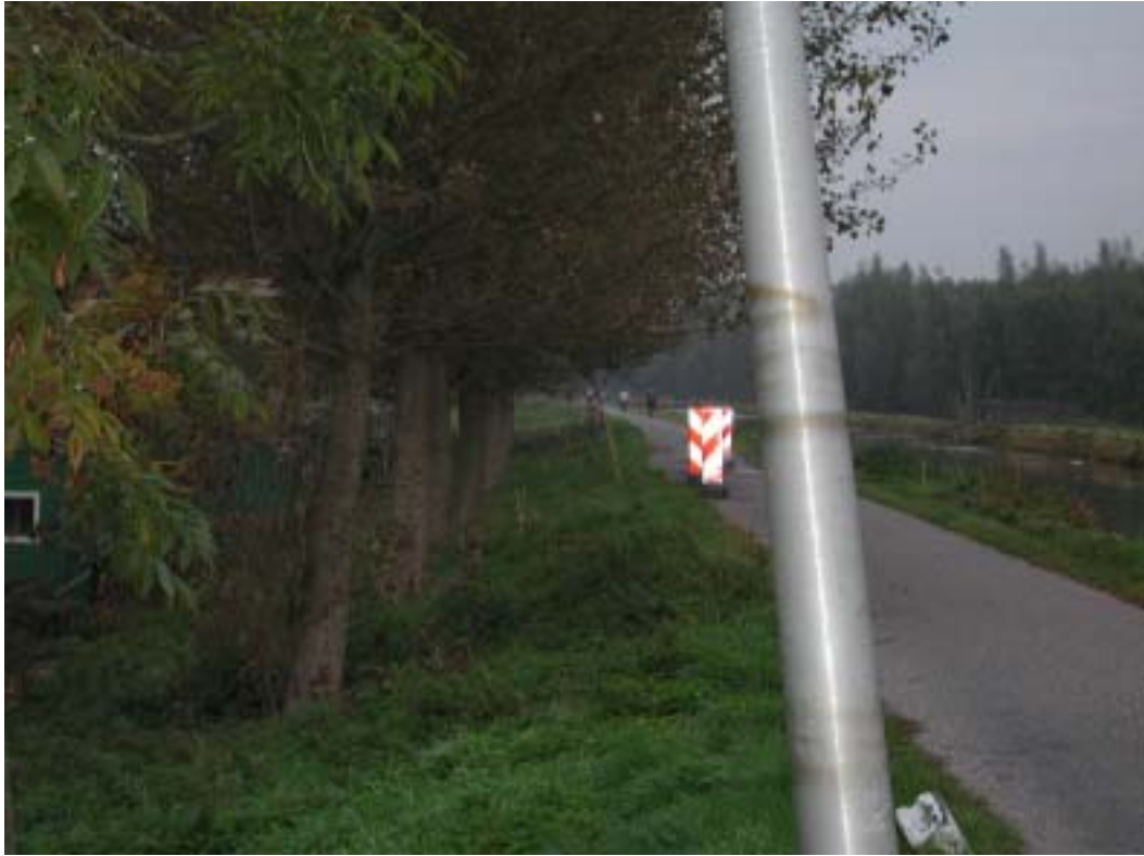
PIJNACKER NOORDKADE. BEGIN KIJKRICHTING NAAR HET NOORDEN. POPULIEREN DIRECT IN DE TEEN NABIJ SCHEURVORMING IN WEGDEK
