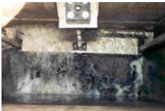
FOTO 3: LEKKAGE SPINDELSCHUIF 1250 MM
