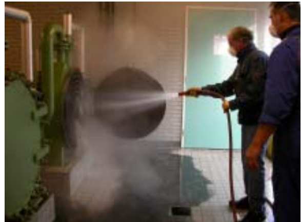
FOTO 5: SCHOONSPUITEN WARMTEWISSELAAR
