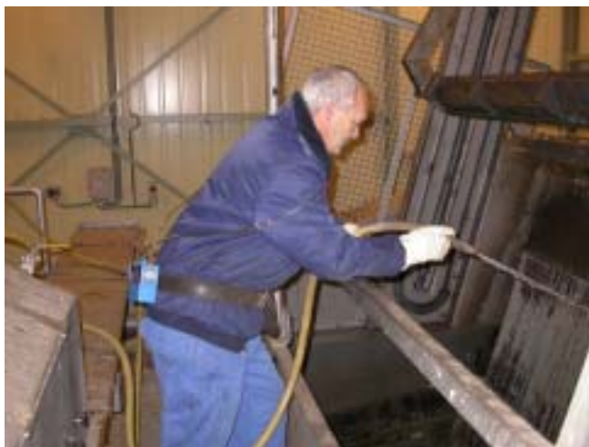
VOORBEELD PERSOONLIJKE METING: SCHOONSPUITEN ROOSTERGOEDVERWIJDERING
