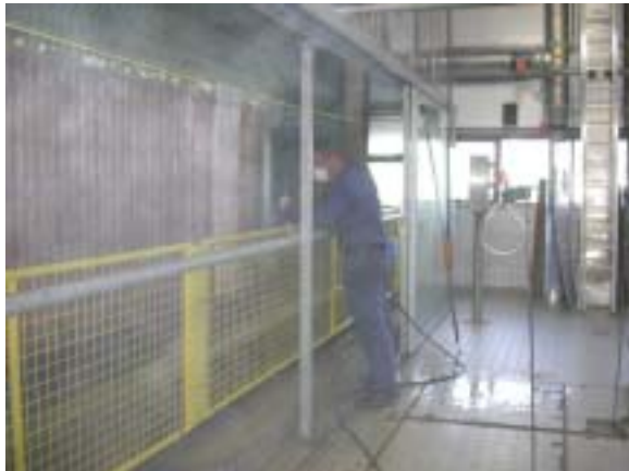
FOTO 4: SCHOONSPUITEN GOOT KAMERFILTERPERS
