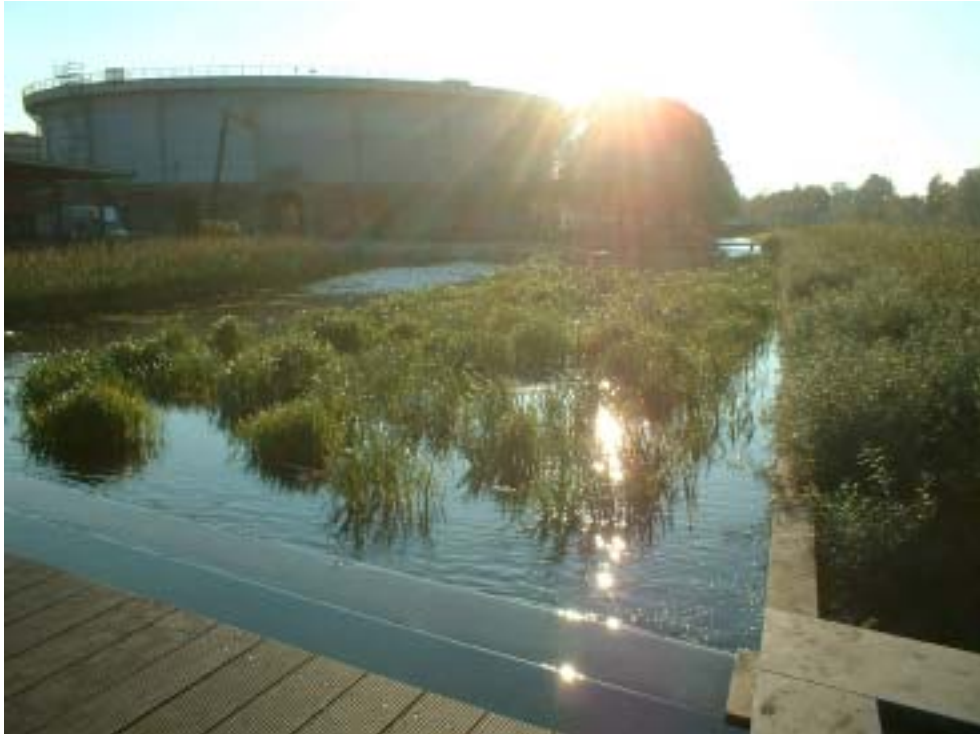
BIOLOGISCHE ZUIVERING AFSTROMEND REGENWATER WESTERGASFABRIEKPARK
