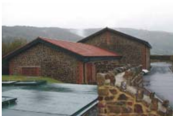
MBR INSTALLATIE PORLOCK
