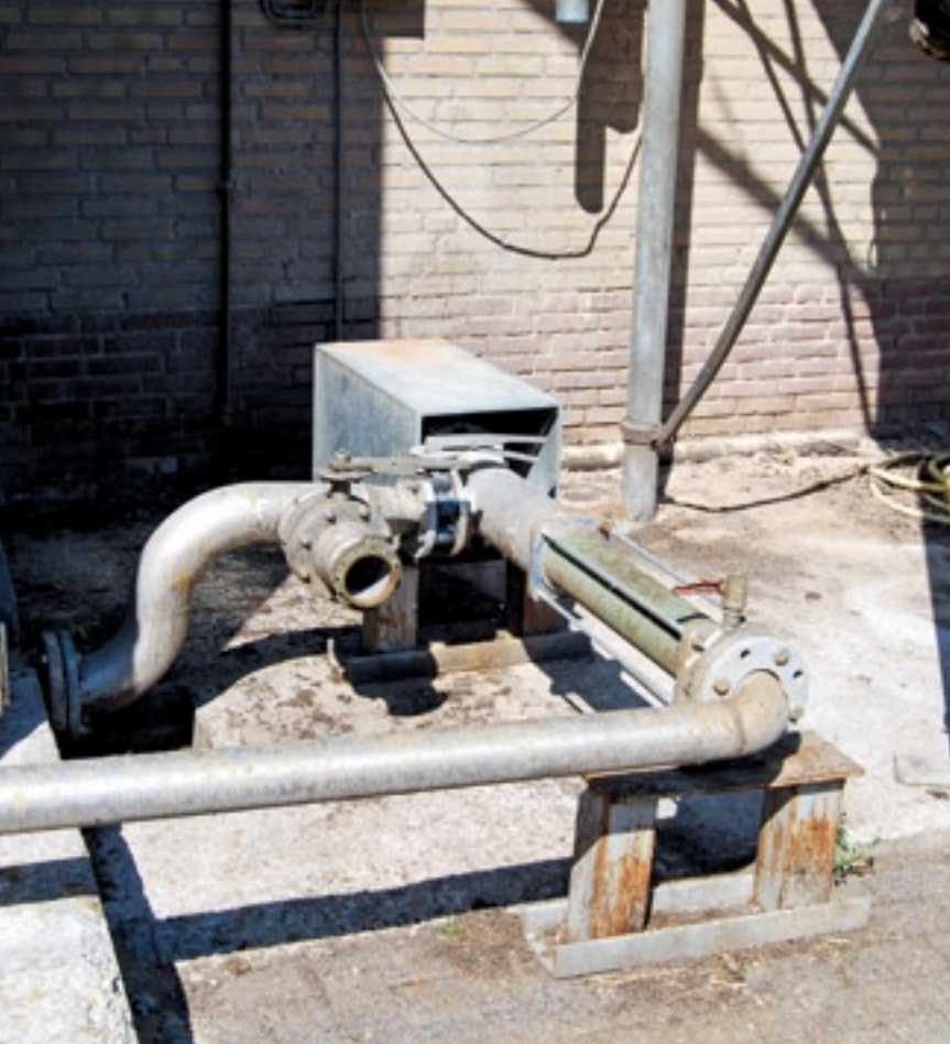
Voor een optimale menging is een pomp alleen niet voldoende. Het advies is om altijd een roerinrichting te installeren.
