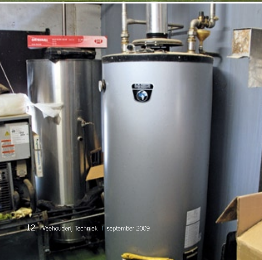
< Een warmteterugwinningsinstallatie kan het spoelwater van de robot alvast voorverwarmen.
