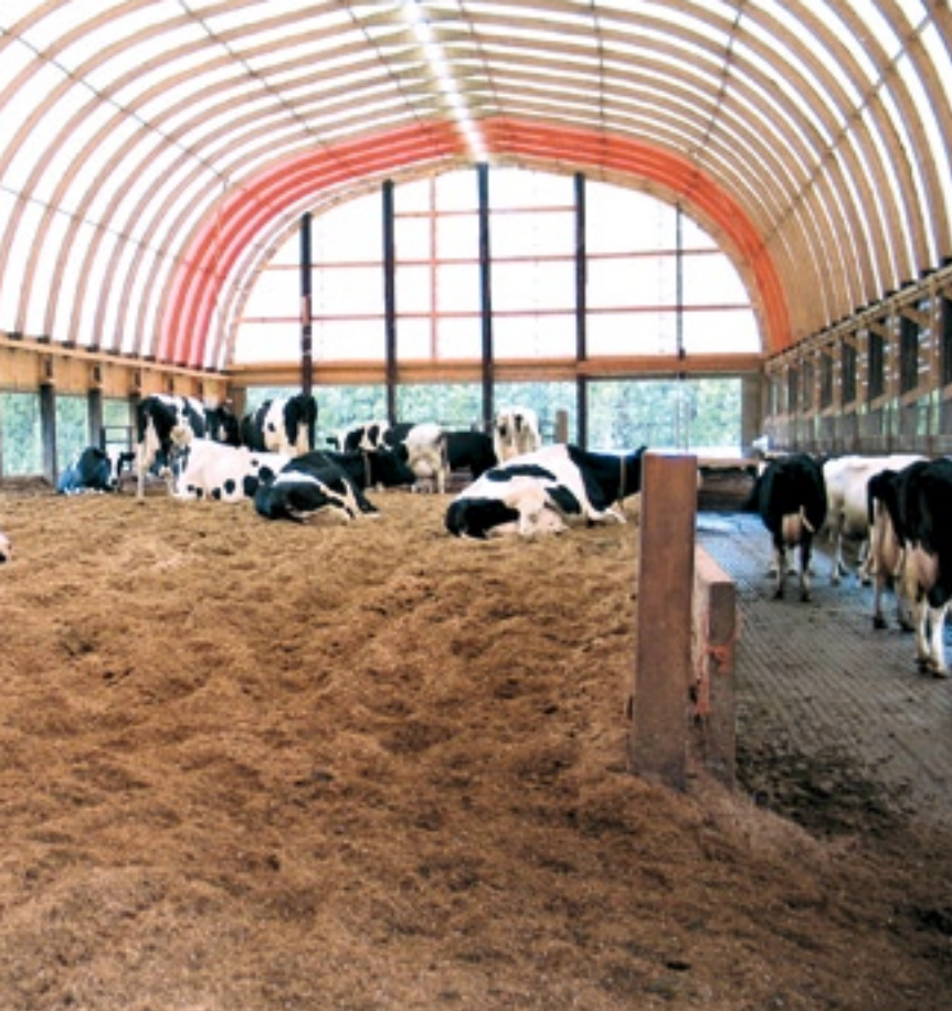
Een betonvloer achter het voerhek en de muur maken een compoststal duur, een eenvoudige bovenbouw drukt de kosten.
