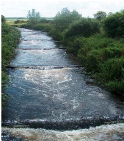
Figuur9 Voorbeeld van een visbekkentrap bij de stuw bij Junne in de Vecht
